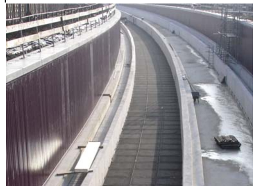
Stap 4: Plaatsen van de verticale matten (indien van toepassing). Gereed om ballast te storten.
