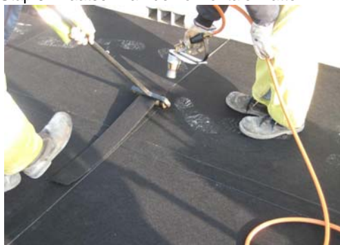
Stap 3: Afwerken van de naden met GF joining strip
