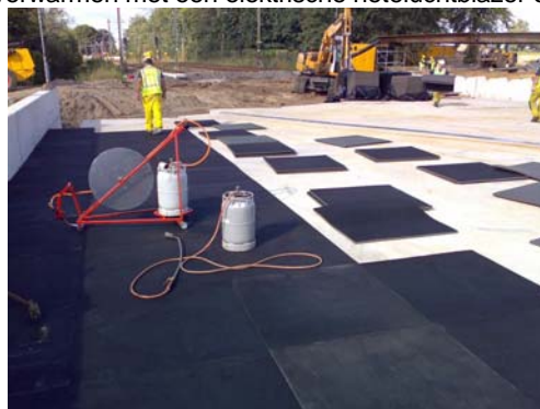
Stap 3: Plaatsen van de horizontale matten
