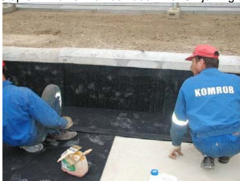
Stap 4: Plaatsen van de verticale matten (indien van toepassing). Gereed om ballast te storten.
